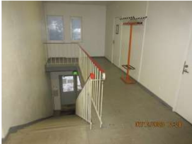
21. 2 krs käytävä ja portaikot on Finflex laatta, joka on liimattu mustalla liimalla kiinni
