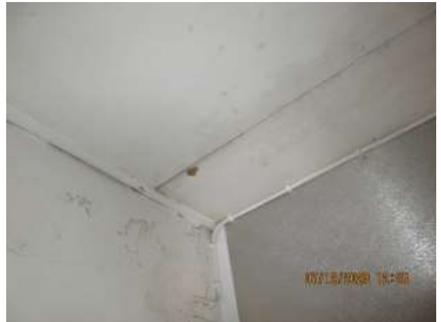
20. 2 krs levykatot ovat kuitulevyä
