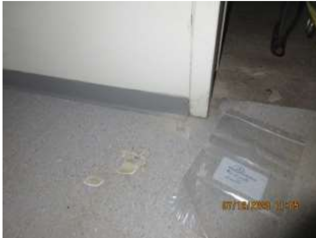
9. Näyte 3, itäpään hallin toimistotilan lattiasta muovimattoa ja tasoitetta
