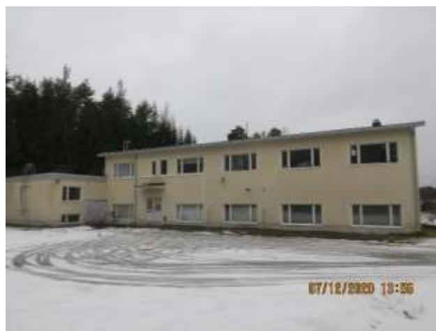
39. Näyte 15. Rappaus, Sokkeli + ulkoseinä
