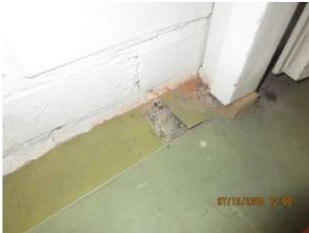
15. Näyte 6, muovimattoa, tasoitetta ja musta-liima välihuoneen lattiasta 2. krs
