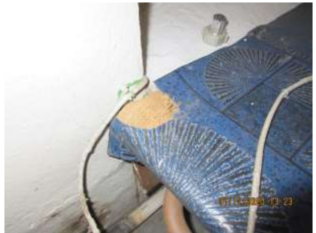
31. ja 32. Keskiahalli I krs, lattiassa Finflex laatta, joka on liimattu mustalla liimalla kiinni
