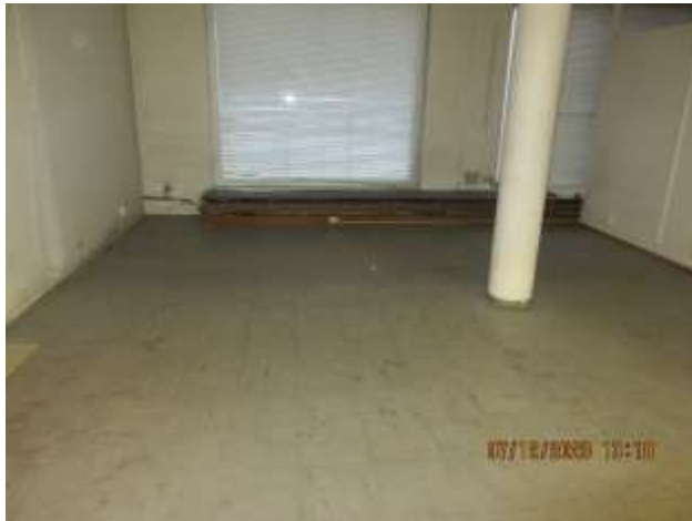
31. ja 32. Keskiahalli I krs, lattiassa Finflex laatta, joka on liimattu mustalla liimalla kiinni
