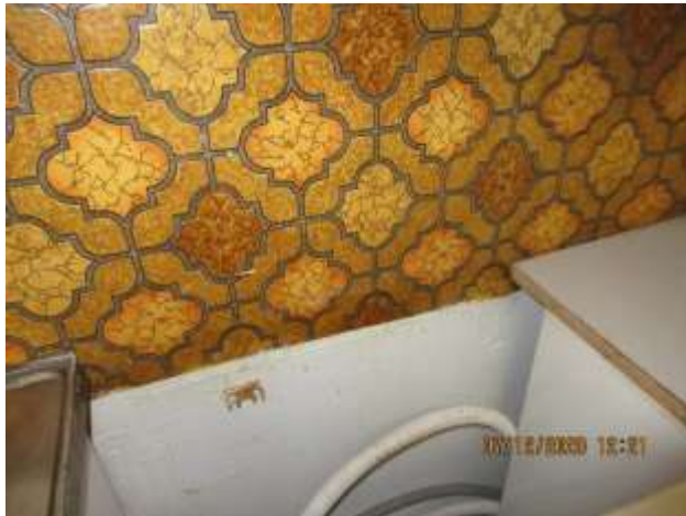
19. Näyte 8. Toisen kerroksen keittiö välitilan matto muovimattoja, kiinnitysliima
