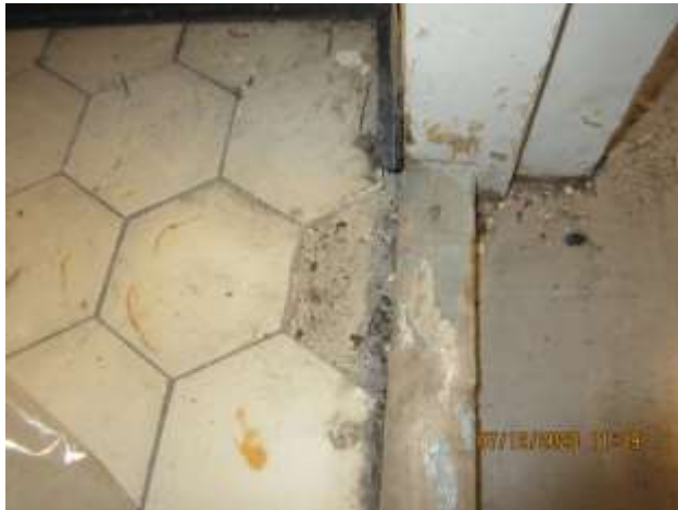
13. Näyte 5, toisen kerroksen suihkutilan lattiaaatta ja laasti
