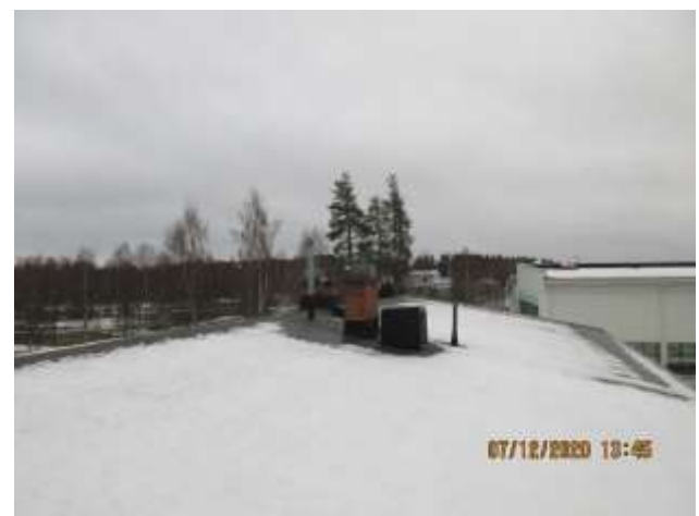
40. Näyte 16. Bitumihuopa, Vesikatto
