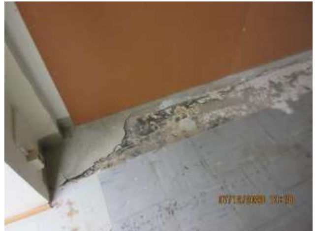
31. ja 32. Keskiahalli I krs, lattiassa Finflex laatta, joka on liimattu mustalla liimalla kiinni
