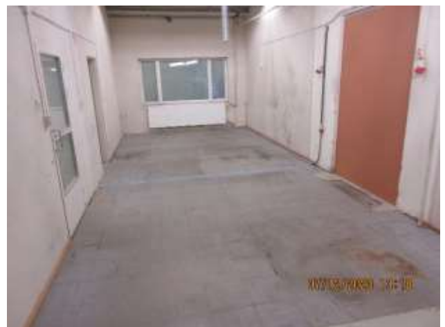
30. Keskihalli I krs, lattiassa Finflex laatta, joka on liimattu mustalla liimalla kiinni
