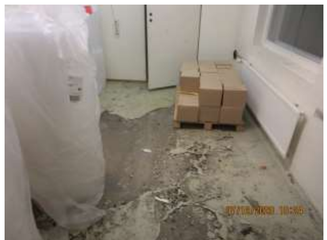
6. Näyte I, länsipään hallin toimiston lattiapinnoitetta ja kiinnikettä
